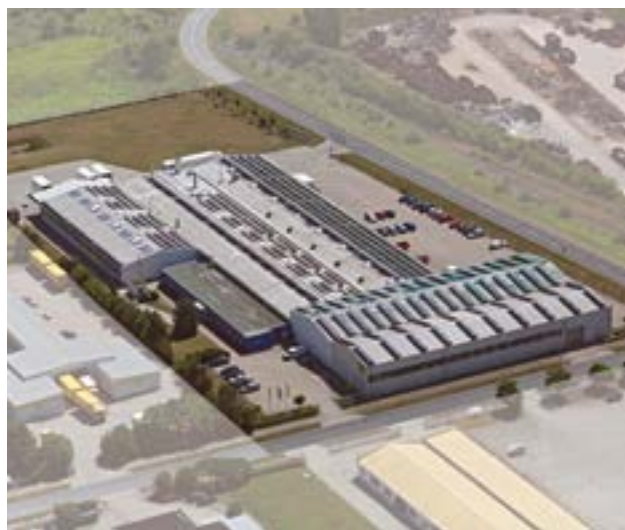
Anlegget i Halberstadt
